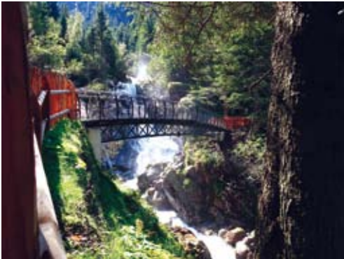
Brücke mit Aussichtsplattform über den Langenbach
